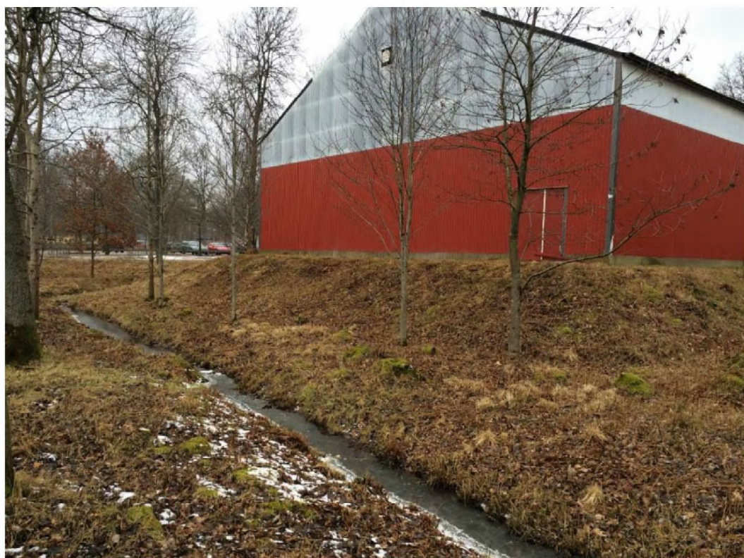
Bild över öppet dagvattendike söder om tennishallen.
