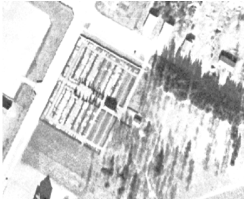
Flygbild från 1960 där området på kommunal parkmark är ianspråktaget.
