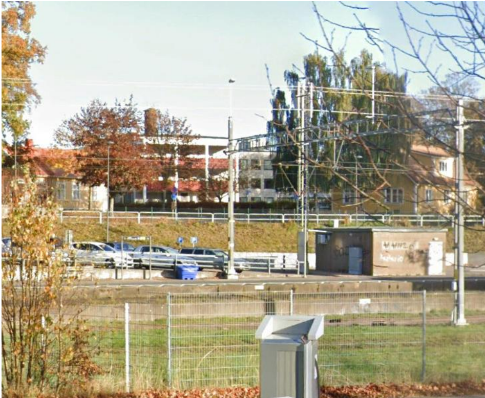
Figur 16. Befintlig byggnad från motsatt sida järnvägen. Höjdskillnaden är 5-7 meter.
